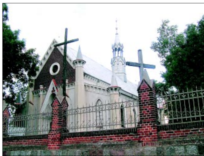
Kościół Parafialny p.w. Św. Mikołaja w Sadlnie; neogotycki, orientowany, trzynawowy; zbudowany w latach 1856 – 1860, rozbudowany w 1865 r.
